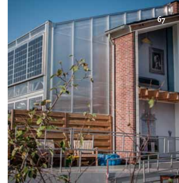
Op deze foto is goed te zien hoe de 'kas' over het bestaande huis heen is gebouwd.
